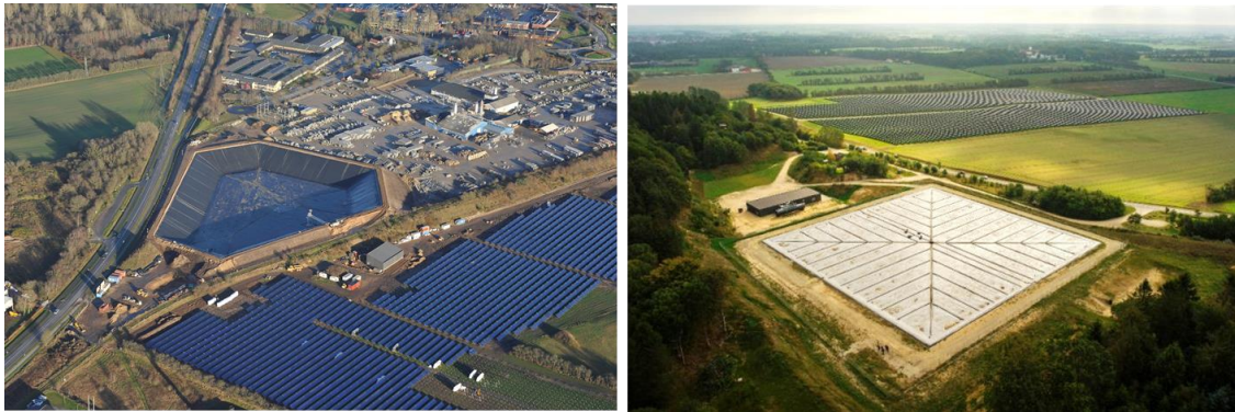
Afbeelding 11.9 Voorbeelden grootschalige thermische putten. Links: Vojens, Denemarken (in aanbouw, 200.000 m 3 ) 1 . Rechts Dronninglund, Denemarken (60.000 m 3 )
